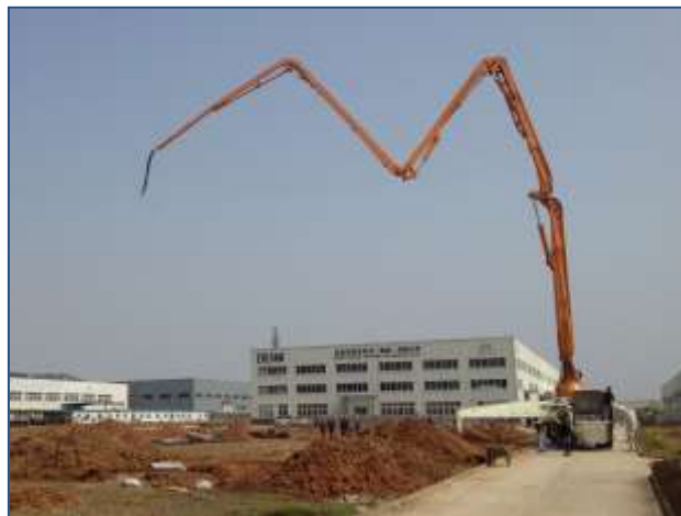
Marts 2013 – fundament støbes
