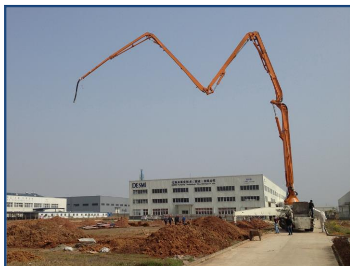
Så pumpes der beton
